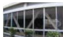
美濃工場耐震補強対策
