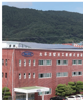
韓国子会社の太陽光発電設備
