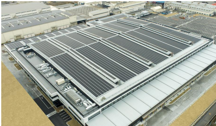
東大垣工場第4工場および厚生棟に設置した太陽光パネル
