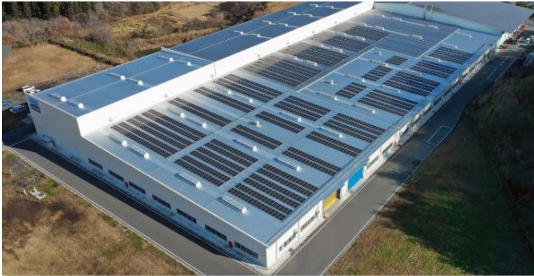
太陽光パネルを設置した栗原工場
