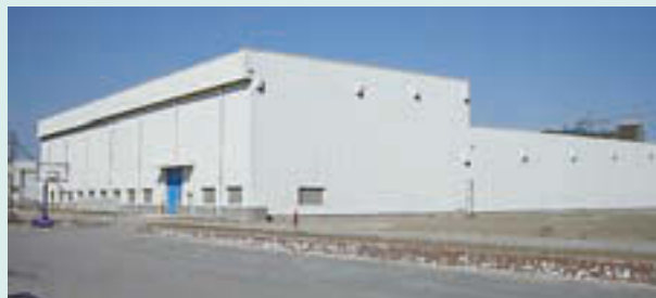
天津太平洋汽車部件有限公司の第二期工事
