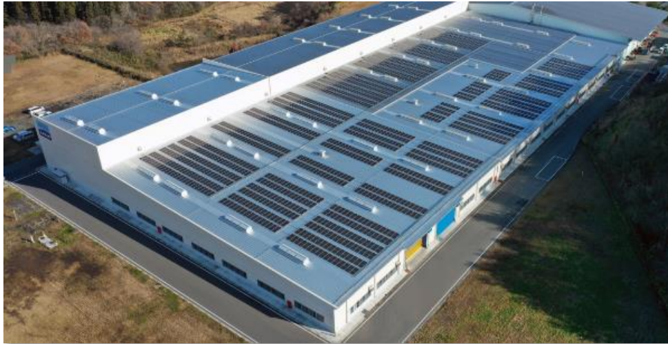
太陽光パネルを設置した栗原工場
