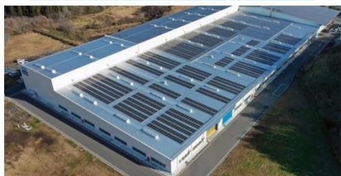
太陽光パネルを設置した栗原工場
