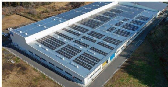
太陽光パネルを設置した栗原工場
