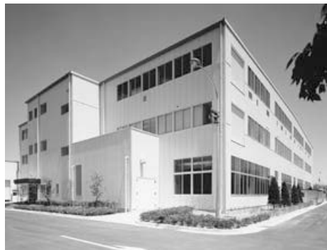
完成した北大垣第3工場 (1994年)
