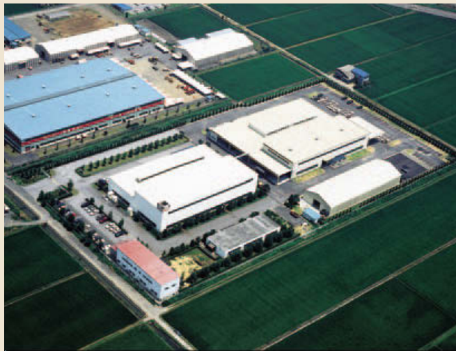
養老第2工場建設 プレス製品事業部の再構築として、養老工場敷地内に建設。ラッゲージヒンジは、パイプ切断・曲げ・組付けの一貫生産ができる日本一の専門工場となった（1991年:H3）
