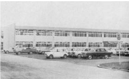
完成した西大垣工場技術センター（1970年）
