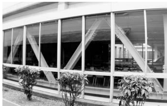
建物の耐震補強 (2004年)
