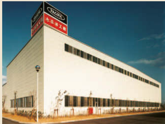
養老工場建設 プレス用金型の専門工場として建設(1982年:S57)
