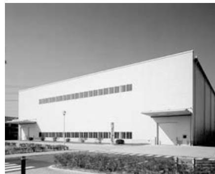
防振・防音対策完備の 新プレス工場完成 (2002年)
