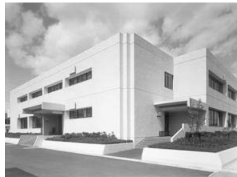
完成した第2本館 （1980年）
