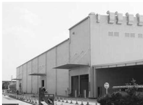
東大垣第3工場建設(2006年)
