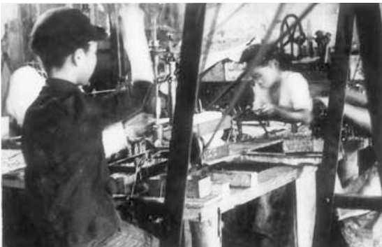
バルブコア切削作業 (1937年頃)
