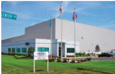
樹脂工場完成
