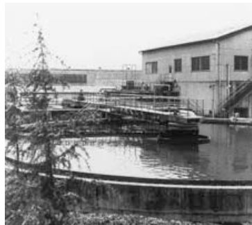
総合排水処理施設（1970年）
