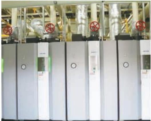
小型貫流型ボイラー導入により、燃料を重油から都市ガスへ転換
